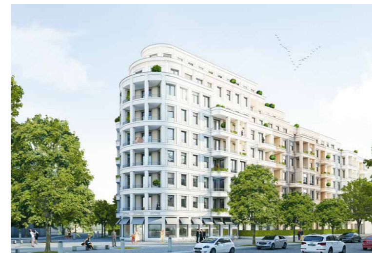
Neubauprojekt Diamona & Harnisch (Carré Voltaire)
