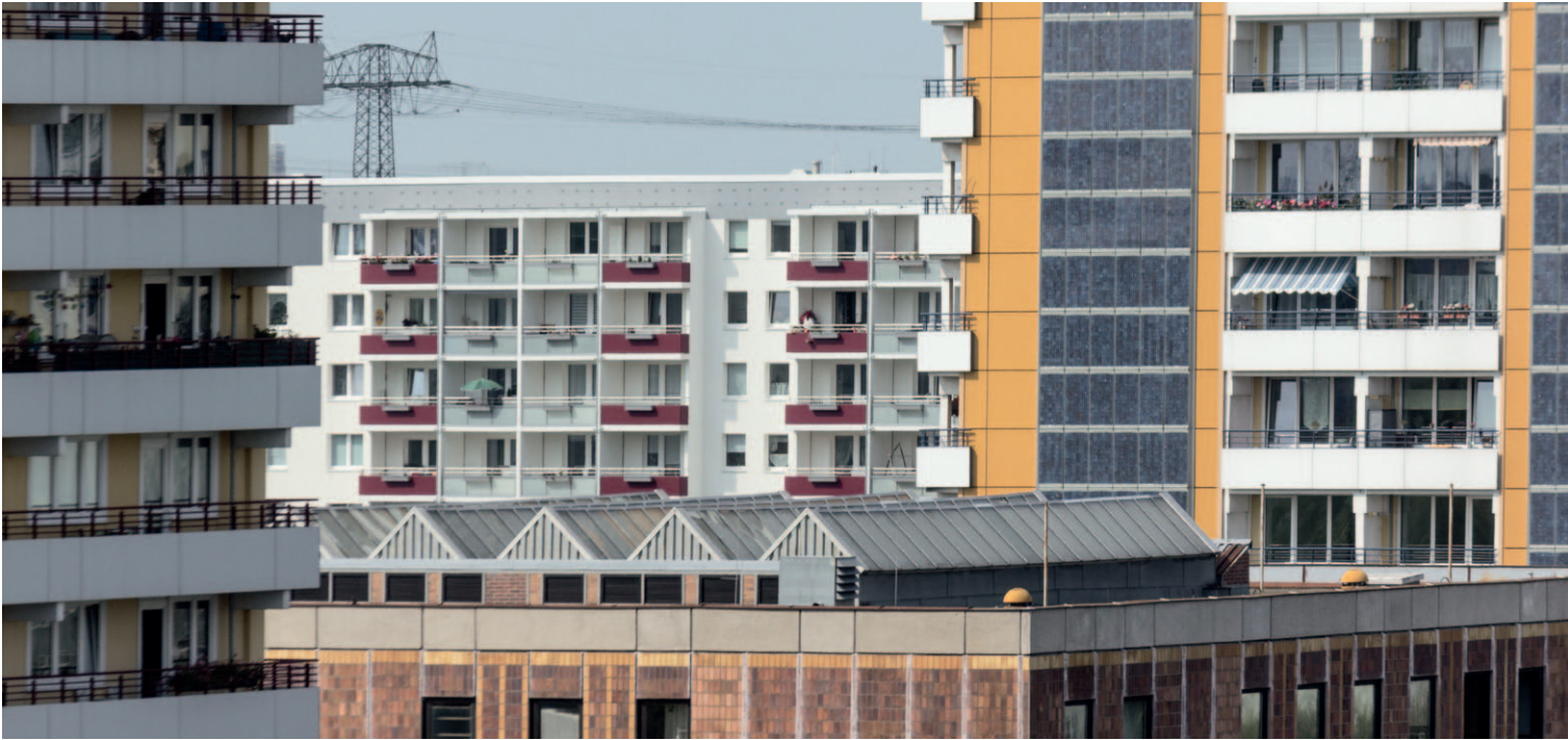
Preisgünstig und praktisch: Modernisierte Wohnhäuser und ein Handelsgebäude in einem der Dienstleistungszentren in den DDR-Neubauquartieren von Marzahn-Hellersdorf
